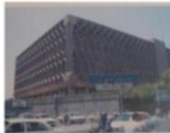
• ساختمان پست تهران و سیستم تفکیک
